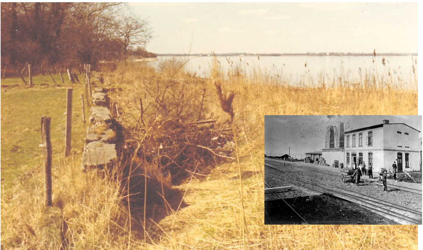
Resterne af ålebassiner ved Tamdrup Strand som Chr. Damkjær byggede i 1910 . De var bestilt af Amtsbanen Haderslev , men kom aldrig rigtig i brug. Man kan forestille sig drømmen om et åleeventyr, som også skulle give arbejde til æ'kleinbahn. Foto: Arkiv.dk Filetfabrikken, da der var ålerøgeri.
