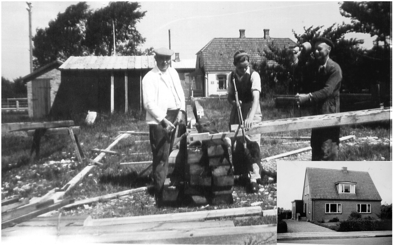
Der laves spær på Færgevej 50 – til nybyggeri Færgevej 33. På billedet ses murer Hannibal Dall, en snedkerlærling og snedker Hans Hansen. Det lille billede viser Færgevej 33 færdigbygget. Foto: Ragnhild Christensen
