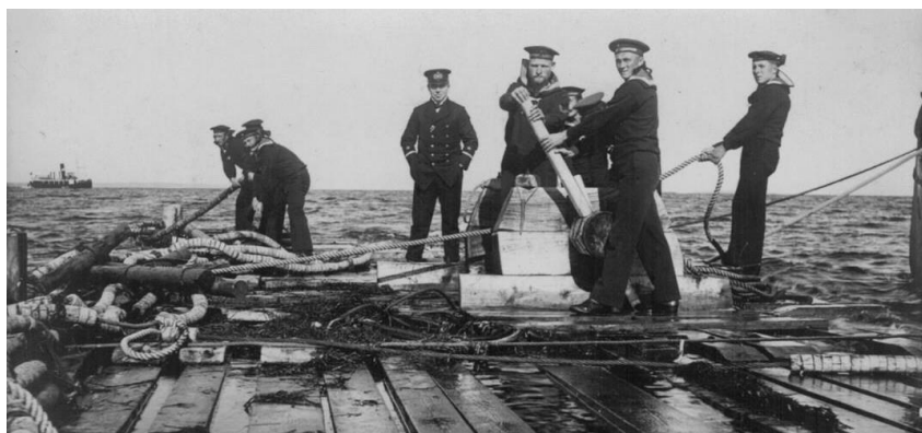
Udlægning af ubådsnet fra pram, Aarøsund.
